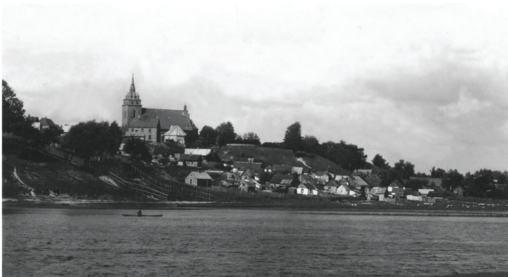
Widok na miasto od strony rzeki - lata 30-te
